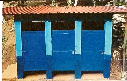
Foto 6: Recubrimiento de techo con pintura anticorrosiva y pintada de paredes del módulo de letrinas.
