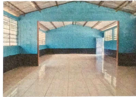
Foto 2: Instalación de piso (porcelanato) ejecutado al 100% (interior del módulo) (Renglón IV)
