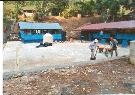
Foto 4: Entortado de patio frontal de la escuela. Finalizado 100% (Renglón VI)
